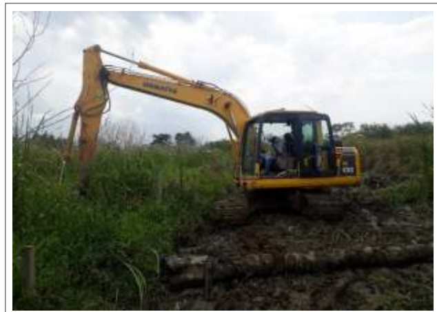
Imagen 13: Jarillón lote Juana Machado
