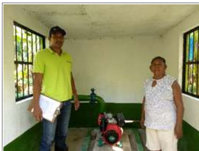
Imagen 2: Finca la Pepa con estación construida
